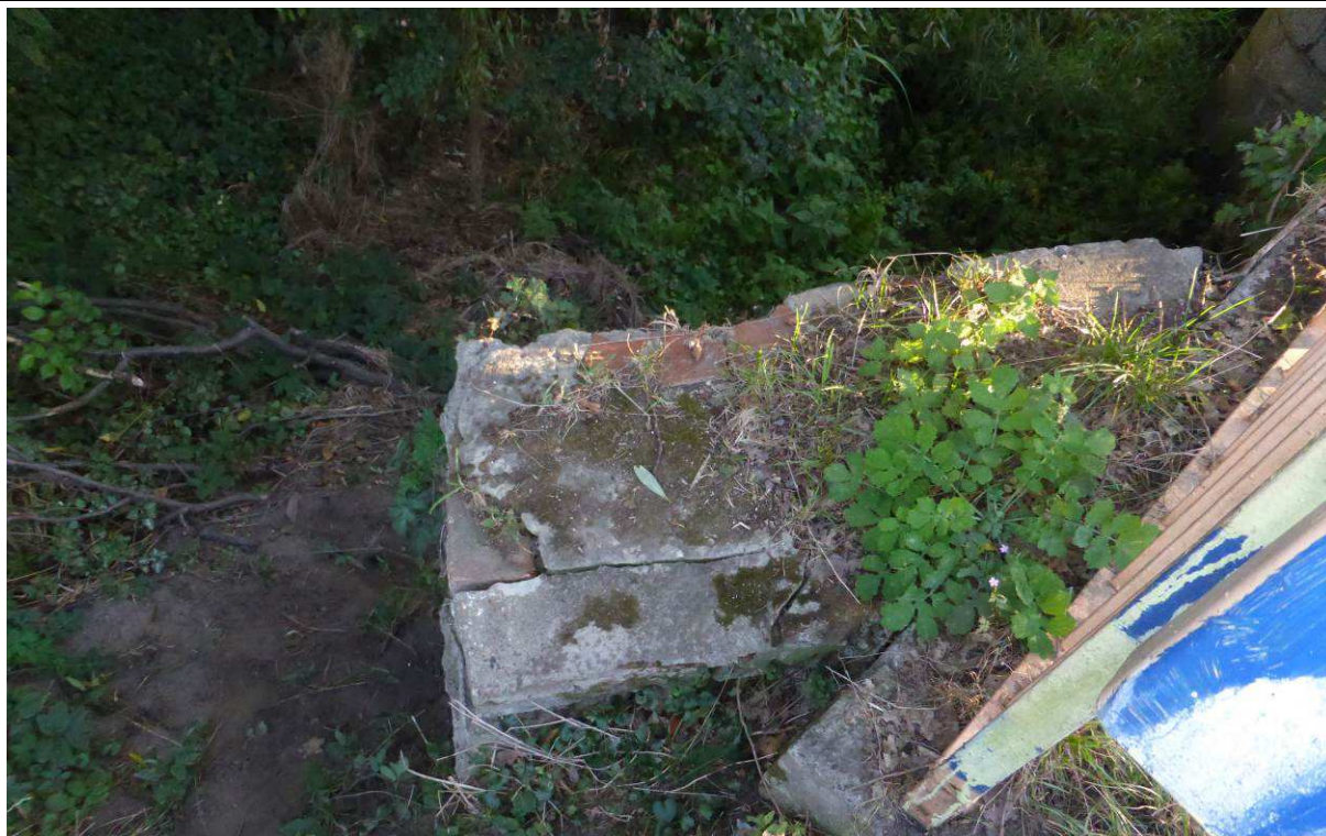
Rys. 10.7. Widok skrzydła przyczółka - najazd od strony Oławy
