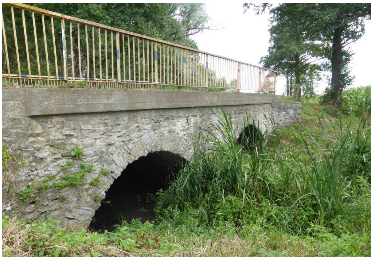
Rys. 10.2. Widok mostu z boku od strony WD z prawego brzegu
