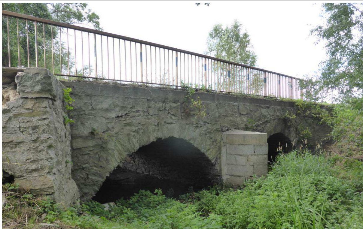
Rys. 10.1. Widok mostu z boku od strony WG z lewego brzegu
