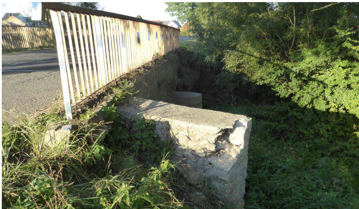
Rys. 10.6. Widok skrzydła przyczółka - najazd od strony Oleśnicy Małej
