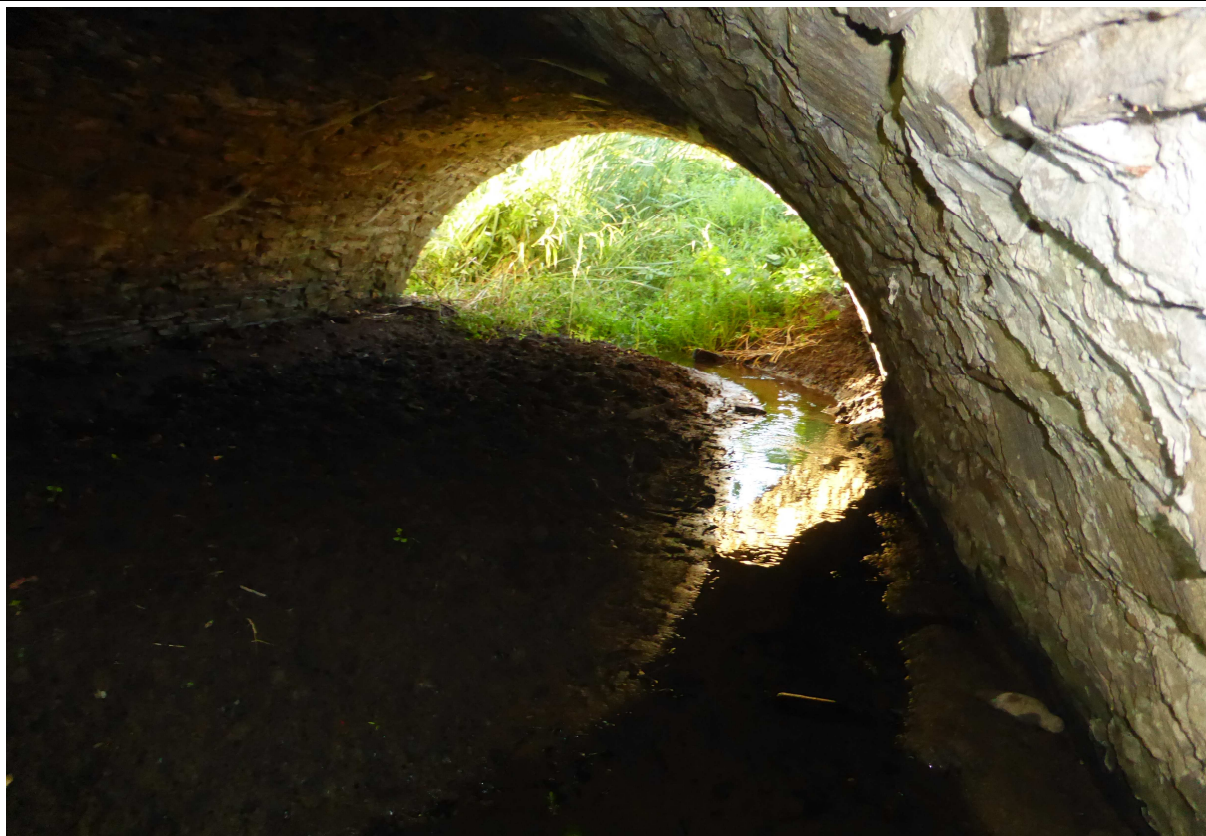
Rys. 10.5. Widok terenu pod mostem - sklepienie od strony Oławy
